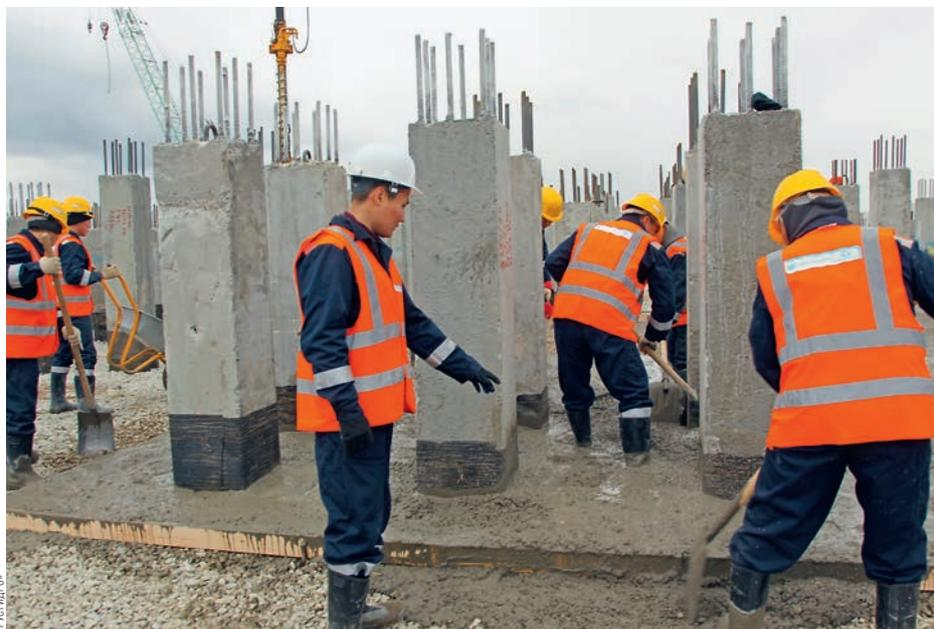
ЯКУТСКАЯ ГРЭС-2 УЖЕ СТРОИТСЯ. НА ФОТО — ПОДГОТОВКА К УСТРОЙСТВУ ФУНДАМЕНТНОЙ ПЛИТЫ
