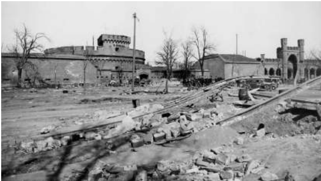
РАЗРУШЕННАЯ ПЛОЩАДЬ ПЕРЕД КРЕПОСТЬЮ. ЦЕНТР КЕНИГСБЕРГА
