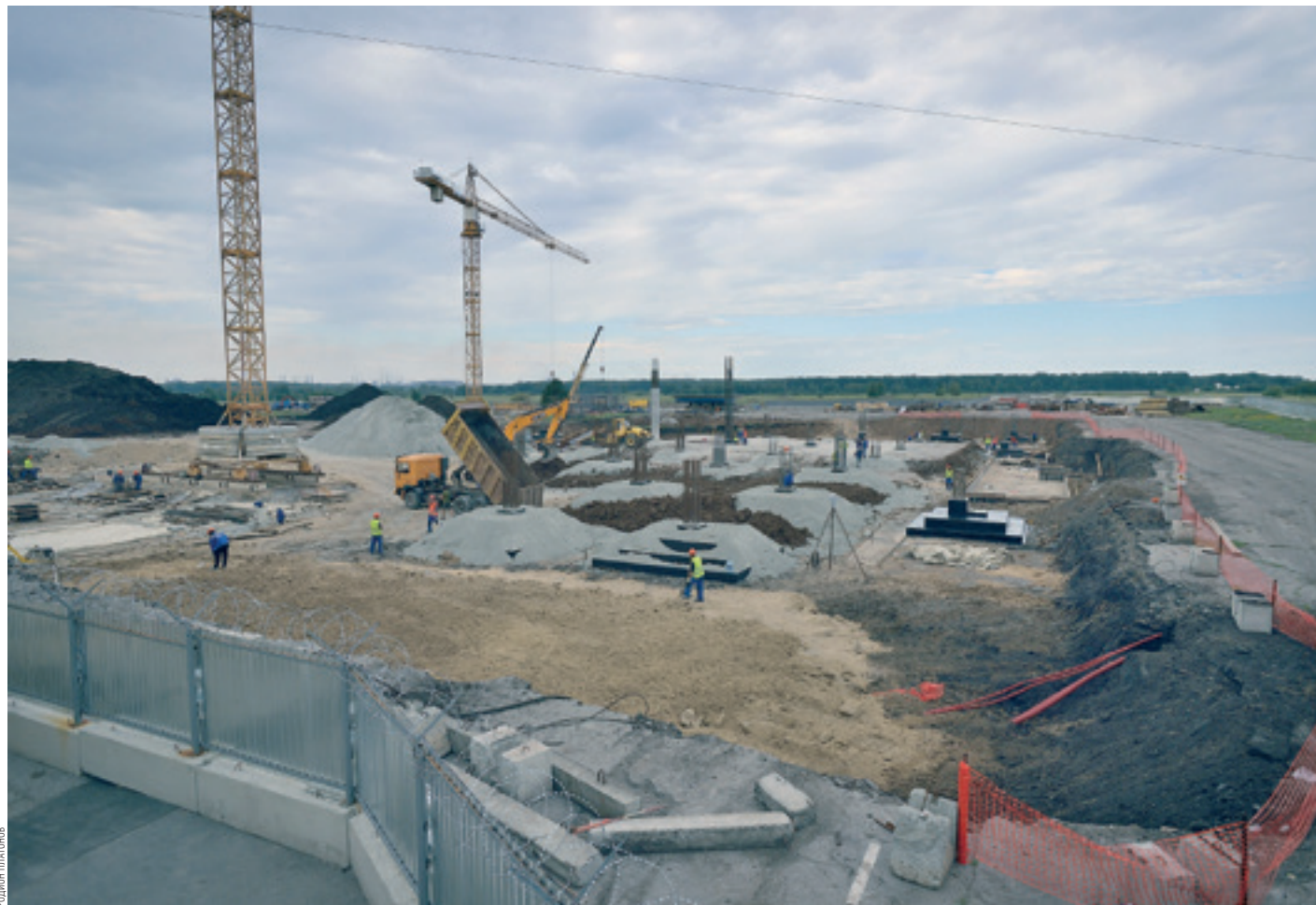
СТРОИТЕЛЬСТВО ПЕРВОЙ ОЧЕРЕДИ НОВОГО АЭРОПОРТА НАЧАЛИ ЭТИМ ЛЕТОМ И ОБЕЩАЮТ ЗАКОНЧИТЬ К 2020 ГОДУ
