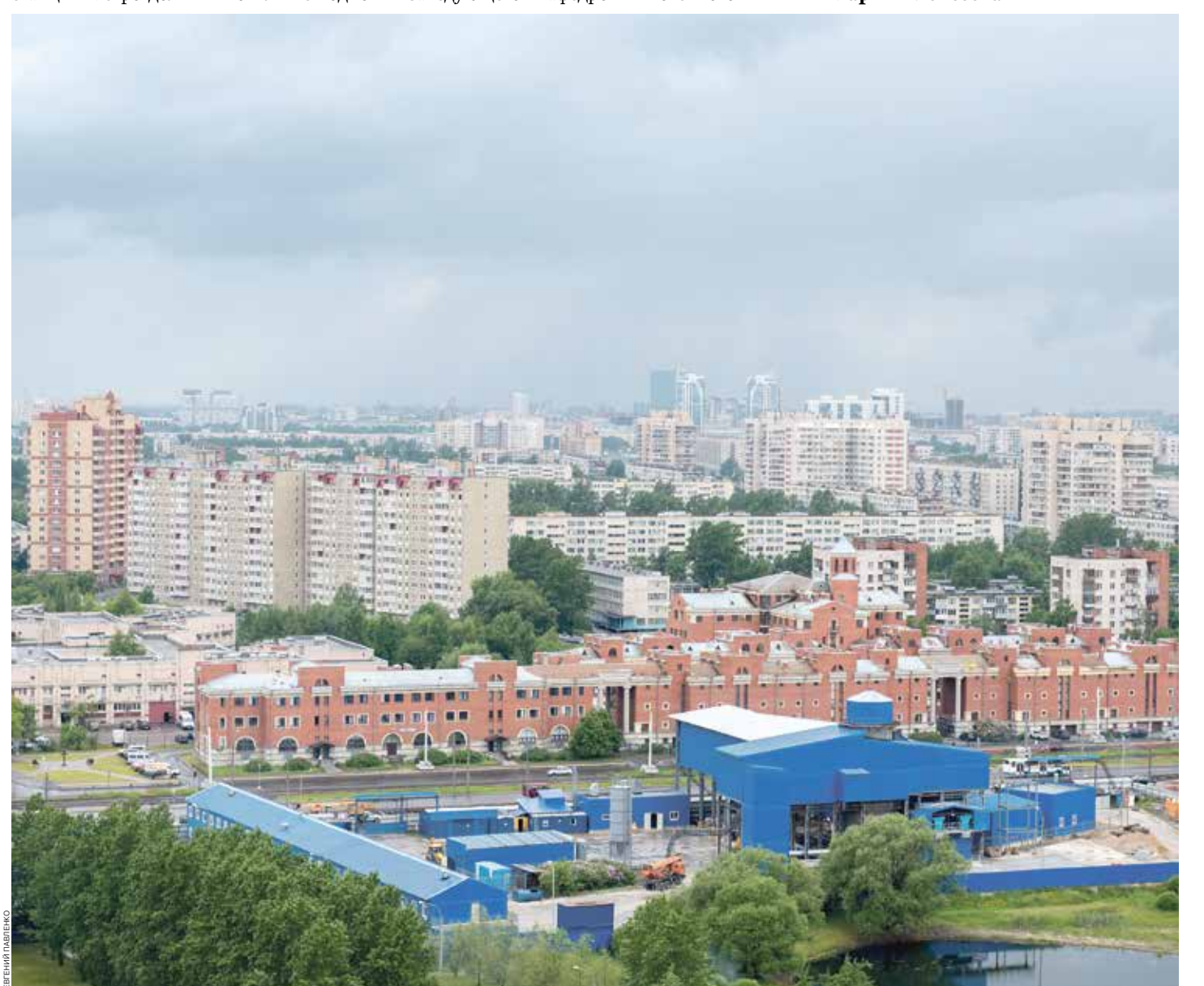
Одна из основных проблем развития метрополитена в Петербурге — отсутствие плана его развития в градостроительном ключе, а также непроведение оперативной экспертизы проектных решений
