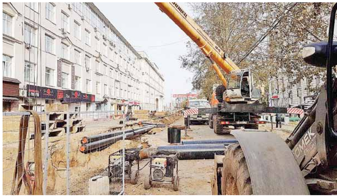
При подготовке к отопительному сезону 2017–2018 в Перми обновлено 14 км магистральных и более 8 км распределительных теплосетей
