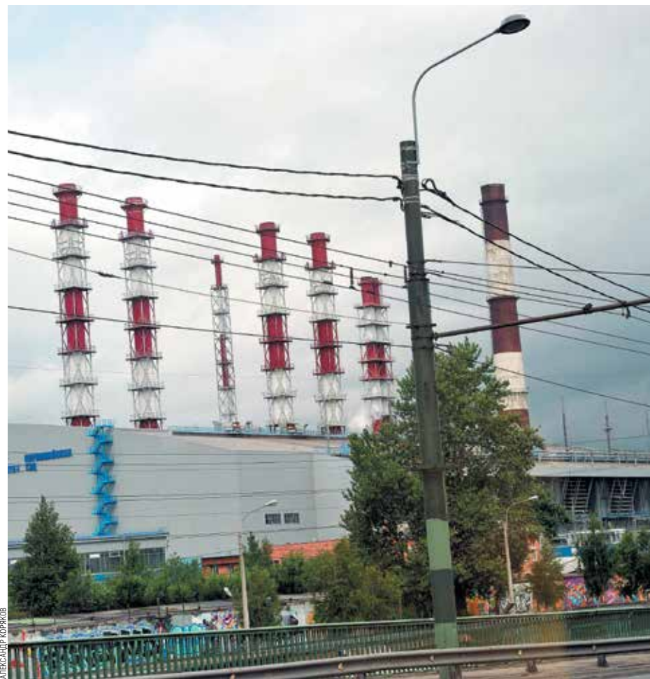
РЕКОНСТРУКЦИЯ ПЕРВОМАЙСКОЙ ТЭЦ БЫЛА НЕОБХОДИМА, ПОСКОЛЬКУ ЕЕ ОБОРУДОВАНИЕ ДОСТИГЛО ПРЕДЕЛЬНОГО ТЕХНИЧЕСКОГО СОСТОЯНИЯ
