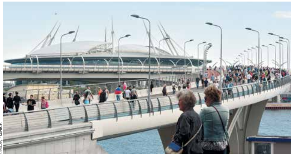
ЕЩЕ ОДНИМ ТРАНСПОРТНЫМ ПРОЕКТОМ, РЕАЛИЗОВАННЫМ В РАМКАХ ПОДГОТОВКИ К ЧЕМПИОНАТУ МИРА, СТАЛО СТРОИТЕЛЬСТВО ПЕШЕХОДНОГО ЯХТЕННОГО МОСТА, КОТОРЫЙ ОБЕСПЕЧИВАЕТ ДОСТУП БОЛЕЛЬЩИКОВ К НОВОМУ СТАДИОНУ. ПЕРЕПРАВА СОЕДИНЯЕТ БЕРЕГ ПРИМОРСКОГО РАЙОНА И КРЕСТОВСКИЙ ОСТРОВ. ДЛИНА МОСТА 492 МЕТРА, ШИРИНА 17 МЕТРОВ
