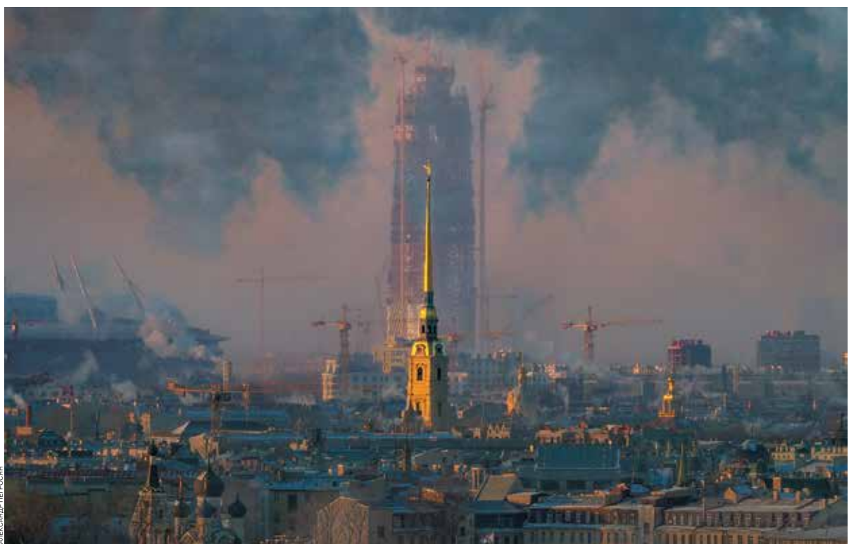
Сегодня в Петербурге главной точкой роста, с которой девелоперское сообщество связывает свои ожидания, является строительство небоскреба «Лакха-центра»
