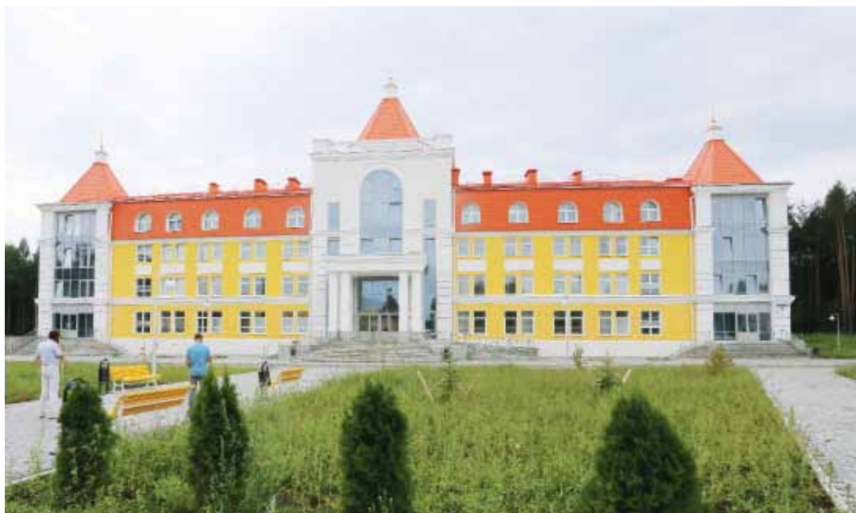
В декабре 2015 года было завершено строительство спального корпуса на 456 мест
