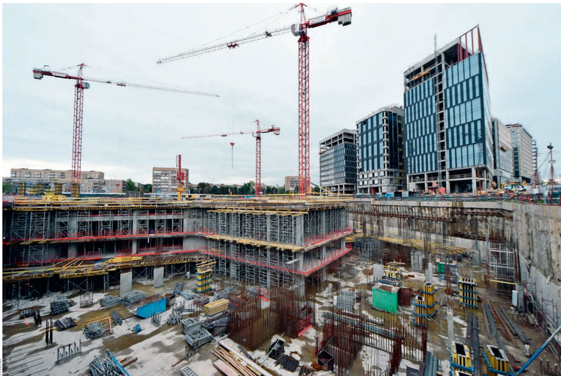
ЧАСТЬ КОРПУСОВ ВЫВЕДЕНА ПОД КРЫШУ, ОСТАЛЬНЫЕ ВЫХОДЯТ ИЗ «НУЛЕВОГО ЦИКЛА»
