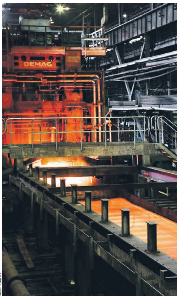
На комбинате «Уральская сталь» ведется комплексная модернизация производства
