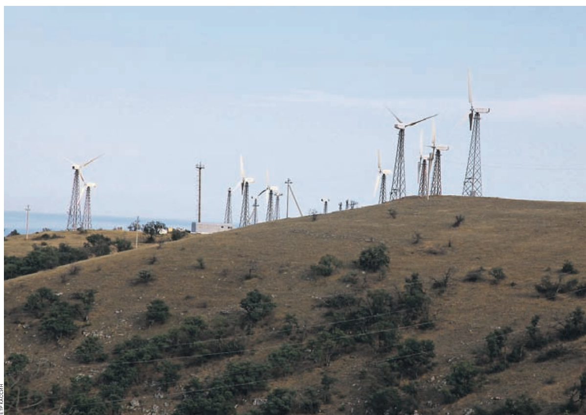
Ветряная электростанция в Крыму. На полуострове до 20% энергии добывается из альтернативных источников
