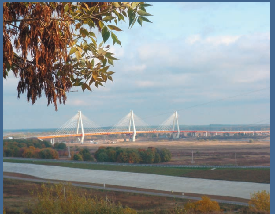
Мост через реку Оку между Муромом Владимирской области и Навашином Нижегородской области обеспечивает бесперебойную связь республик Мордовия, Татарстан, Башкирия и юго-западных районов Нижегородской области с Владимирской областью. Высота пилонов — 86,7 м. Общая длина мостового перехода — 1393 м, ширина — 15 м
