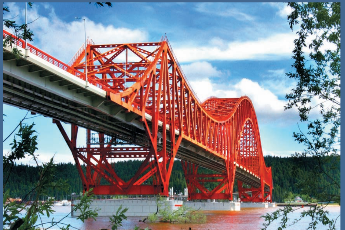
Мост через реку Иртыш («Красный дракон») находится в черте Ханты-Мансийска. Мост расположен на автодороге Ханты-Мансийск — Нягань, являющейся частью федеральной автодорожной трассы Пермь — Серов — Ханты-Мансийск — Нефтеюганск — Сургут — Нижневартовск — Томск. Русловая часть моста представляет собой уникальное, не имеющее в России аналогов стальное неразрезное пролетное строение комбинированной системы типа «арка-ферма-балка». Габариты проезда по ширине — 11,5 м. Габариты проезда по высоте — 5,5 м. Высота подмостовых габаритов — 15 м
