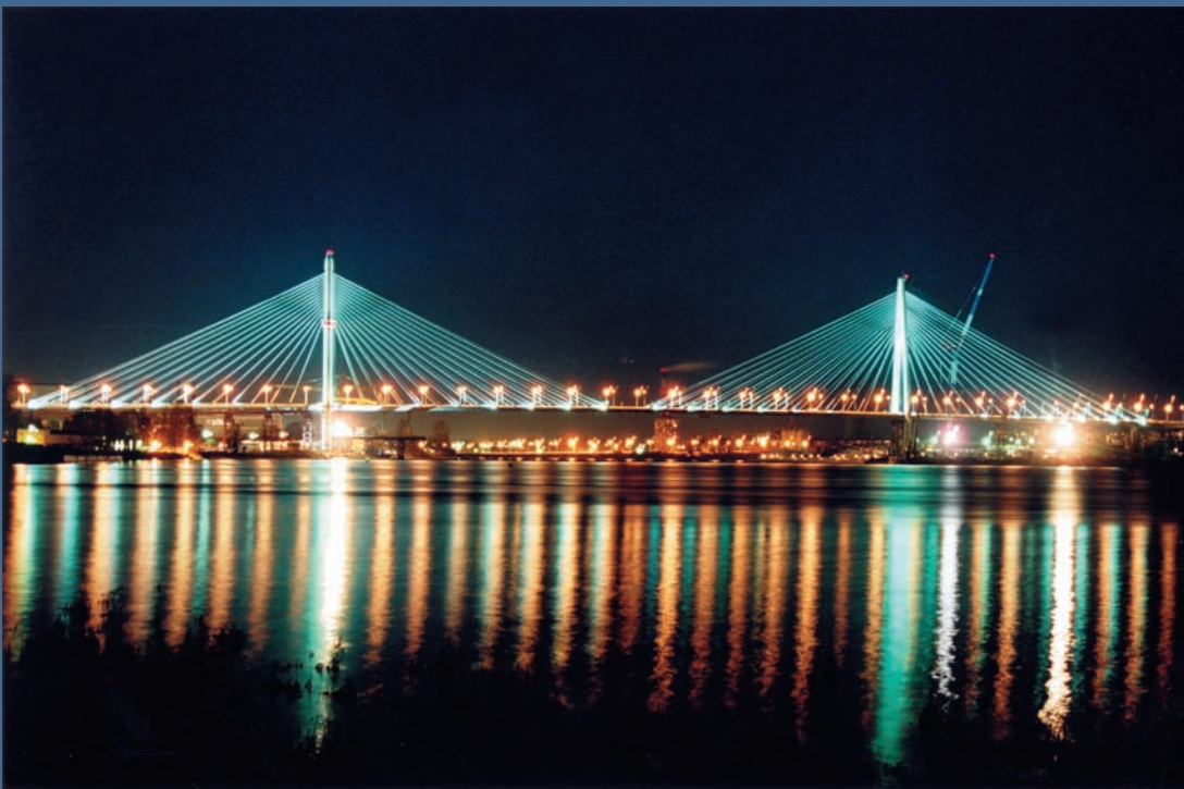
Большой Обуховский мост — вантовый, неразводной мост через Неву. Расположен на границе Невского района Санкт-Петербурга и Всеволожского района Ленинградской области, в среднем течении Невы, соединяет проспект Обуховской обороны и Октябрьскую набережную. Длина мостового перехода — 2,8 км. Расстояние между осями мостов — 36,4 м
