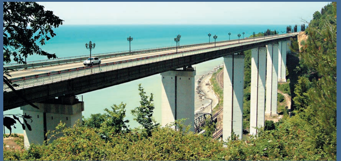
Эстакадный мостовой переход через ущелье реки Чемитоквадже расположен на автодороге Джубга — Сочи в Лазаревском районе Большого Сочи. Высота опор эстакады достигает 80 м, длина эстакады — 576 м
