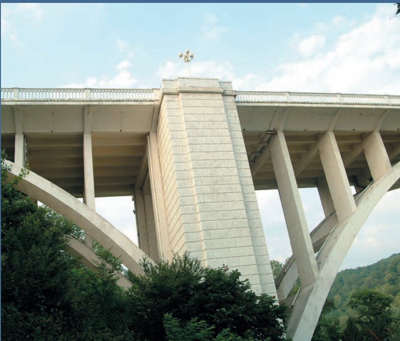
Мост через реку Мацесту на автомагистрали М27. Мацестинский виадук — автодорожный мост в Хостинском районе Сочи. Расположен на федеральной трассе Новороссийск — Сухум (Курортный проспект) над долиной реки Мацесты. Имеет арочную конструкцию. Мост пятипролетный, железобетонный. Его длина — 411 м, ширина — 18, высота — 31 м
