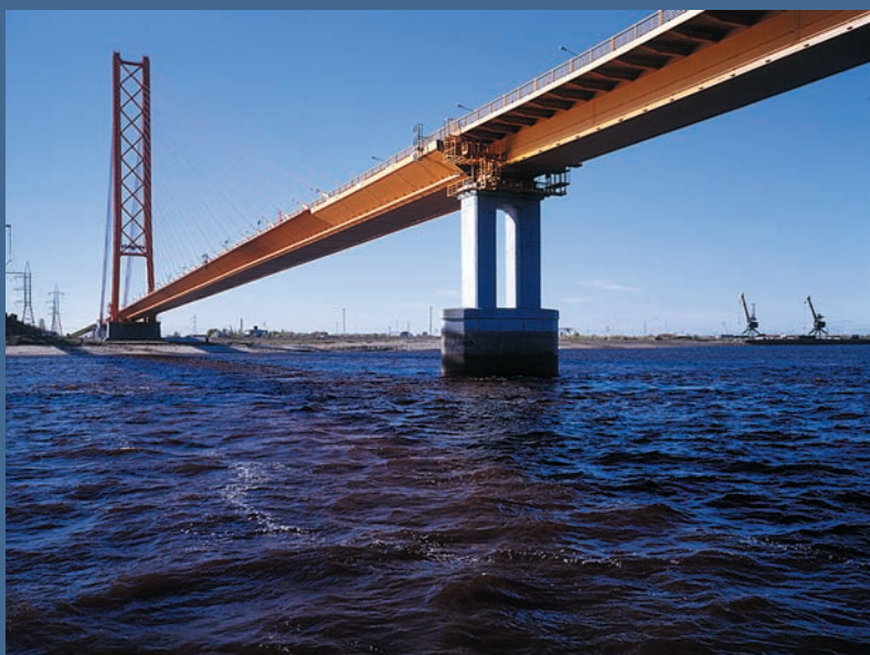
Мостовой переход через реку Обь в районе Сургута. Сургутский мост — вантовый мост через реку Обь, один из самых длинных мостов в Сибири: длина составляет 2110 м (общая длина с подъездами — около 15 км), длина центрального пролета — 408 м. Пролет моста поддерживается одним пилоном высотой 150 м. Мост занесен в Книгу рекордов Гиннеса как имеющий самый большой центральный пролет, поддерживаемый одним пилоном
