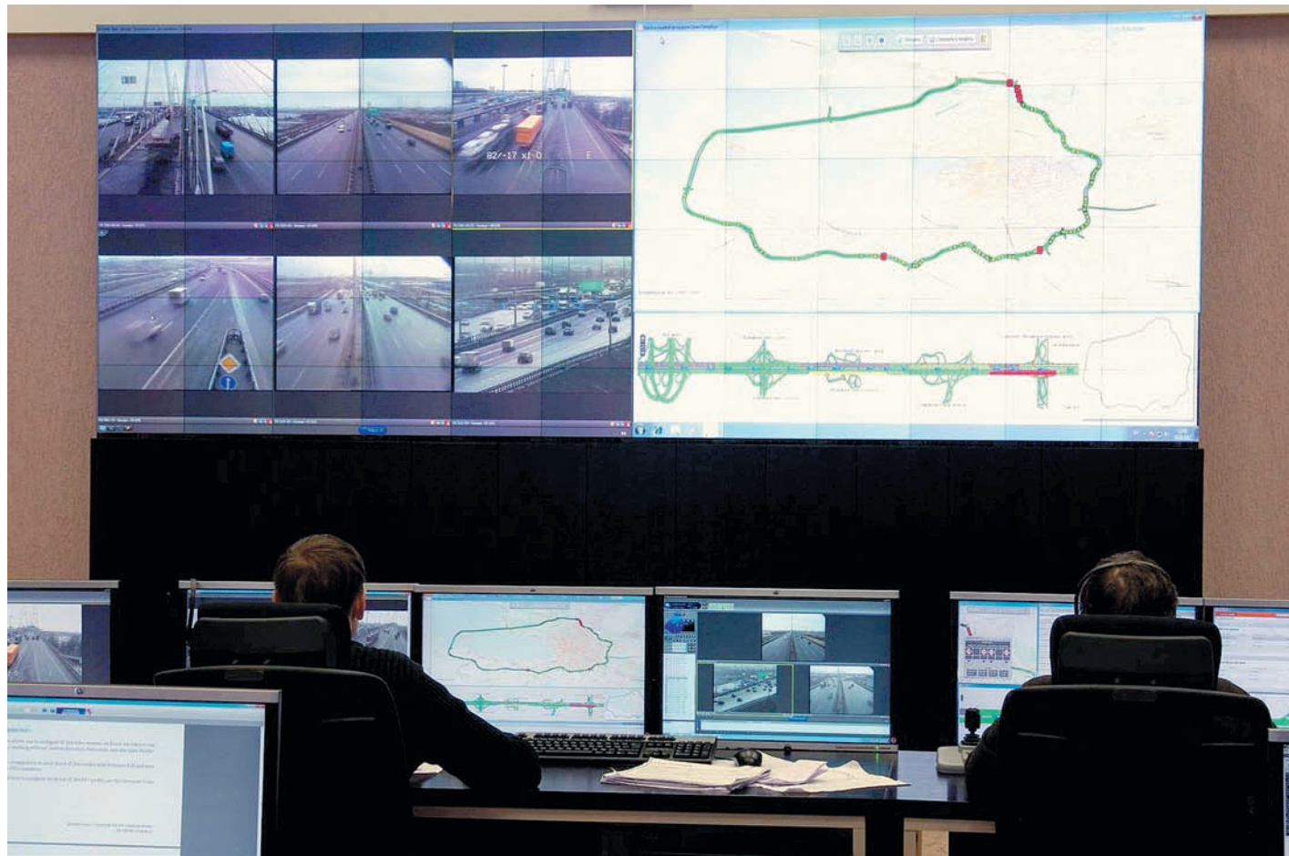
К ИТС НА КОЛЬЦЕВОЙ ДОРОГЕ ВОКРУГ САНКТ-ПЕТЕРБУРГА ОТНОСЯТСЯ СИСТЕМЫ ВИДЕОНАБЛЮДЕНИЯ, МОДЕЛИРОВАНИЯ ТРАНСПОРТНЫХ ПОТОКОВ И РАСПОЗНАВАНИЯ НЕШТАТНЫХ СИТУАЦИЙ
