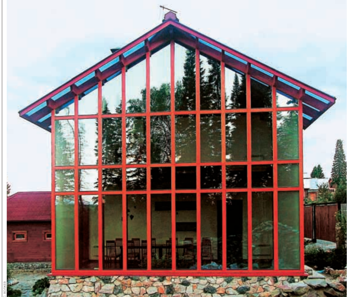
Дом в Кемерове. Стеклоянный фасад надежно защищает обитателей дома от сибирских морозов
