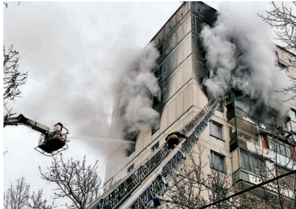
Недавний взрыв газа и пожар в доме на Загородном шоссе соединил большинство страховых случаев: разрушение конструктивных элементов, утрата отделки, затопление водой, гражданская ответственность. ФОТО ИТАР-ТАСС
