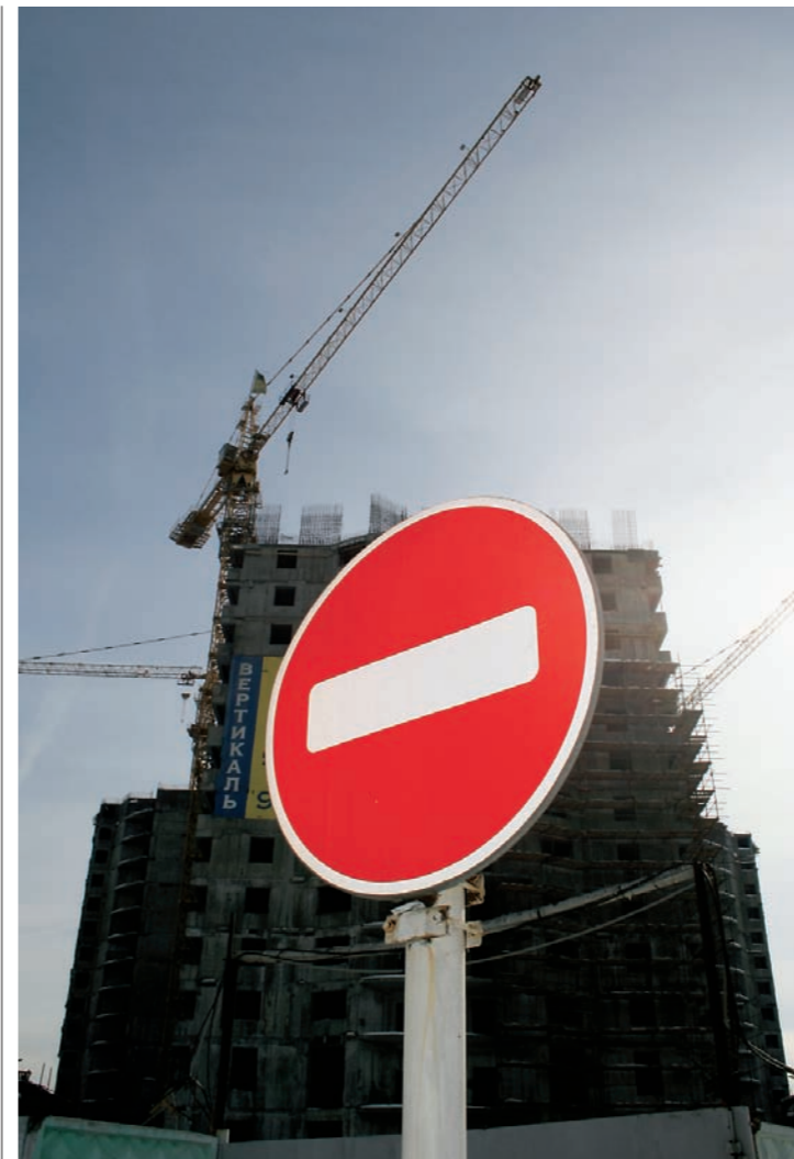
Строительство «Вертикали» на Ленинском проспекте заморожено почти полгода. Жаловаться частным инвесторам будет не на кого. ФОТО ПАВЛА СЕРГЕЕВА
