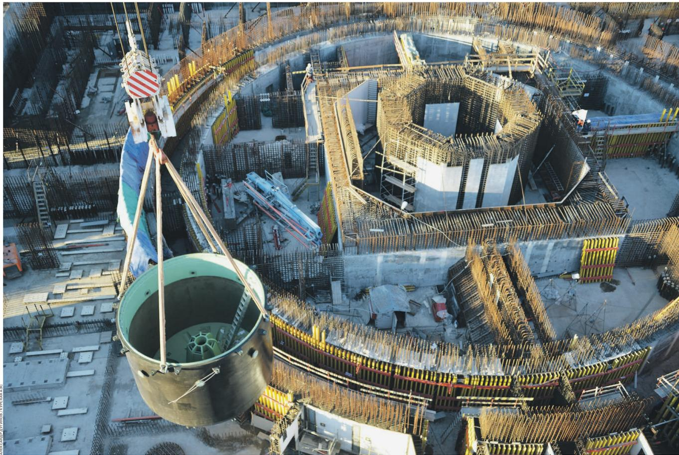
ность — 300 МВт, запуск в 2026–2027 годах). Он станет прототипом более мощного энергоблока со свинцовым теплоносителем на быстрых нейтронах БР-1200.
