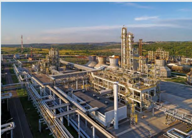
Проведенная модернизация НПЗ «Башнефти» позволила наладить выпуск высокооктанового топлива классов Евро-5 и Евро-6, при этом побочный продукт — газ, содержащий сероводород, полностью перерабатывается благодаря современным
