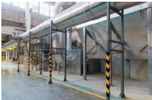
Первая ступень системы очистки дымовых газов — труба «Вентури». Вентури и рукавный фильтр
