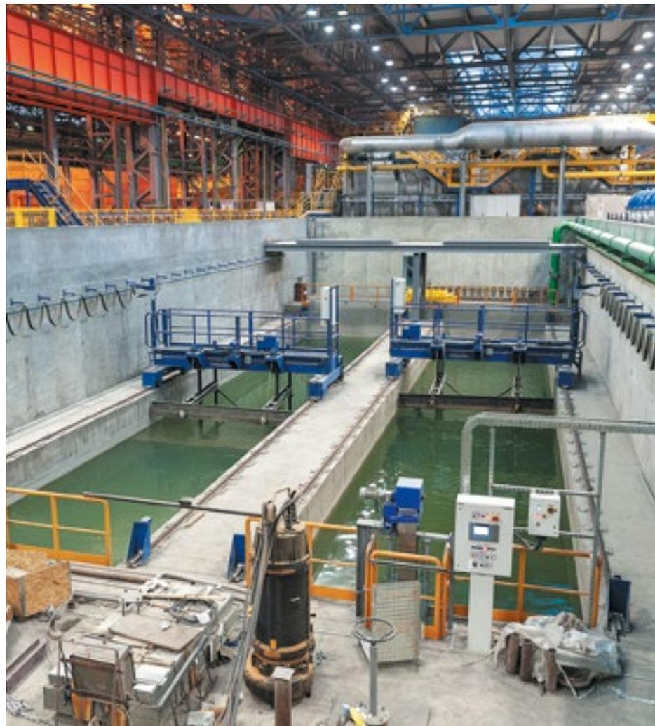
Блок очистных сооружений линии водоподготовки термоотдела №3 ТПЦ-1 СТЗ. Проектная мощность 4000 м<sup>3</sup>/час
