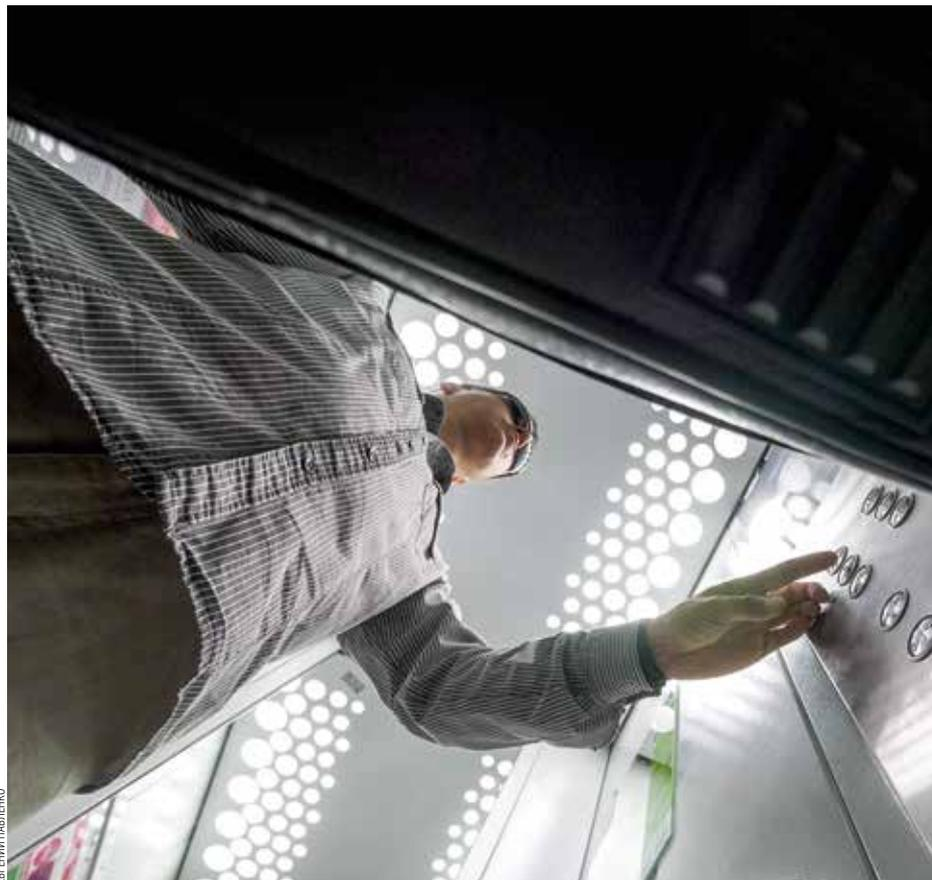
В ЛИФТАХ ДОМОВ КОМФОРТ-КЛАССА ОБЫЧНО СТАВЯТ СВЕТОДИОДНЫЕ ЛАМПЫ С ДАТЧИКАМИ ДВИЖЕНИЯ
