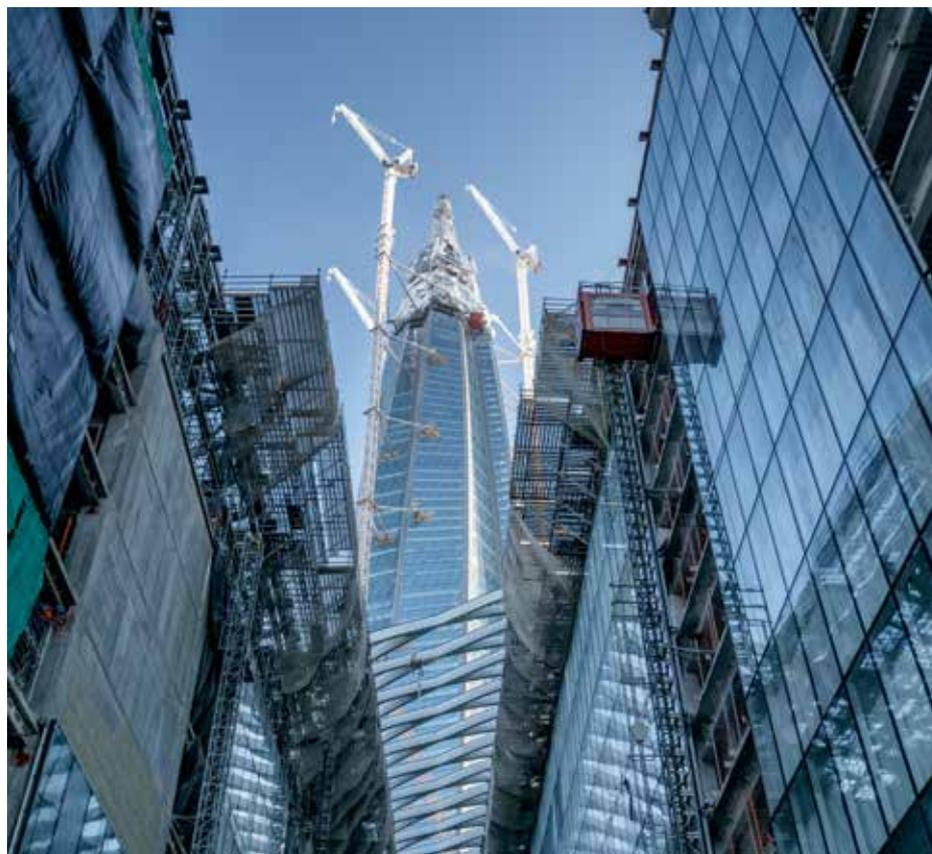
ПРИ ВОЗВЕДЕНИИ КОМПЛЕКСА ИСПОЛЬЗУЕТСЯ КОМПЗИТНЫЙ МАТЕРИАЛ — СТАЛЕЖЕЛЕЗОБЕТОН. БЛАГОДАРИ ЭТОМУ В НЕСКОЛЬКО РАЗ ПОВЫСИЛАСЬ УСТОЙЧИВОСТЬ ЗДАНИЯ, УВЕЛИЧИЛАСЬ НЕСУЩАЯ СПОСОБНОСТЬ КОНСТРУКЦИЙ И НА 20% СОКРАТИЛИСЬ СРОКИ ВОЗВЕДЕНИЯ
