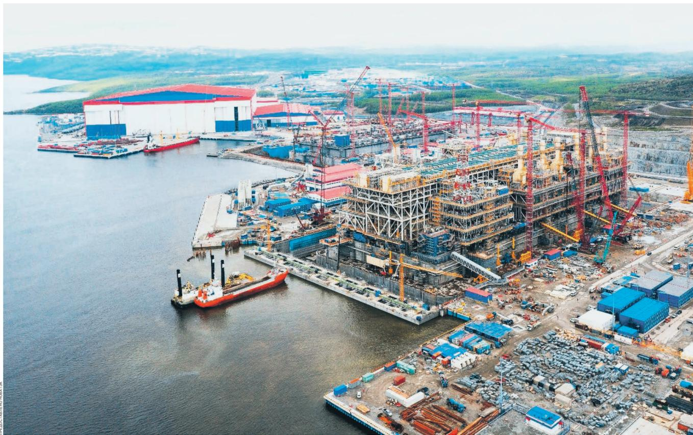
Предприятие работает и создает технологические линии на ОГТ для проекта «Арктик СПГ 2». В двух сухих доках ЦСКМС построены два основания гравитационного типа. На первом ОГТ собраны все технологические модули завода СПГ, сейчас идет их пусконаладка. Вторая платформа отлита и готова к установке на нее модулей.
